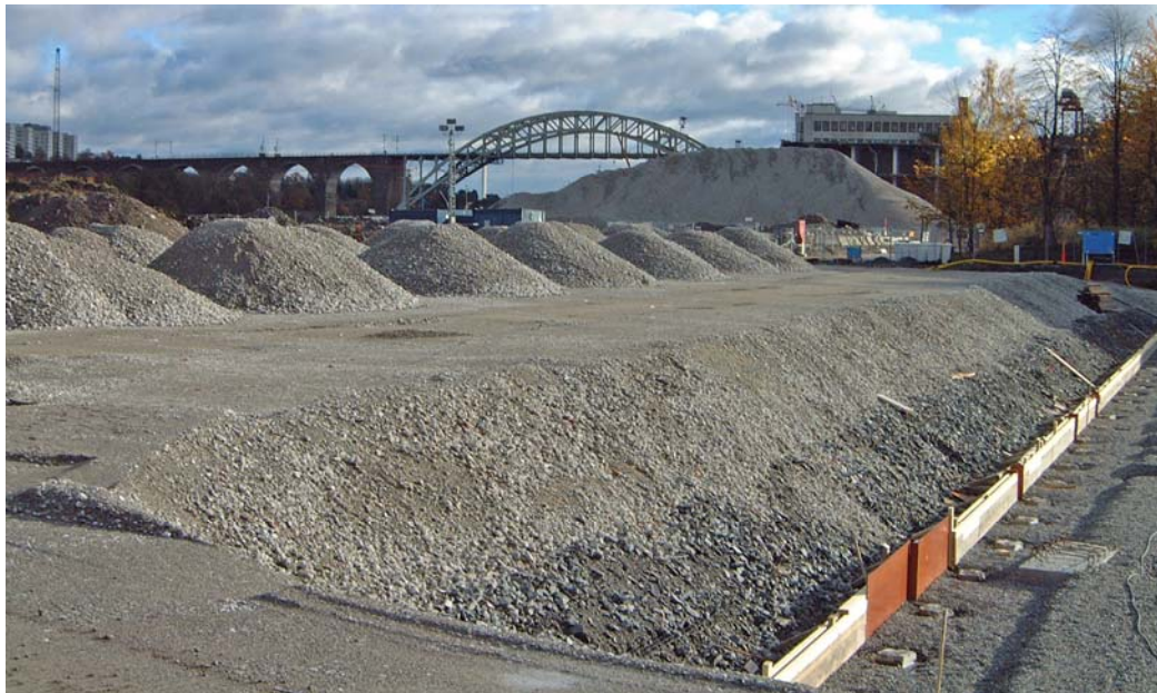
Figur 15.1 Betongkrosshögar och överbyggnad av betongkross på f.d. Vin&Sprints område i Årstadal i Stockholm. Över 50.000 ton betong från rivna byggnader återanvändes som högkvalitativt gatubyggnadsmaterial (JM).
