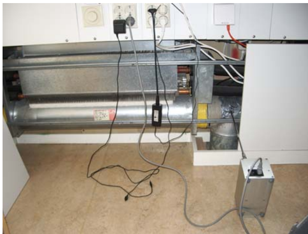
Figur 8.7. Partikelprovtagning av tilluften till fönsterbänksaggregat enligt Semporemotoden. (foto: WSP)
