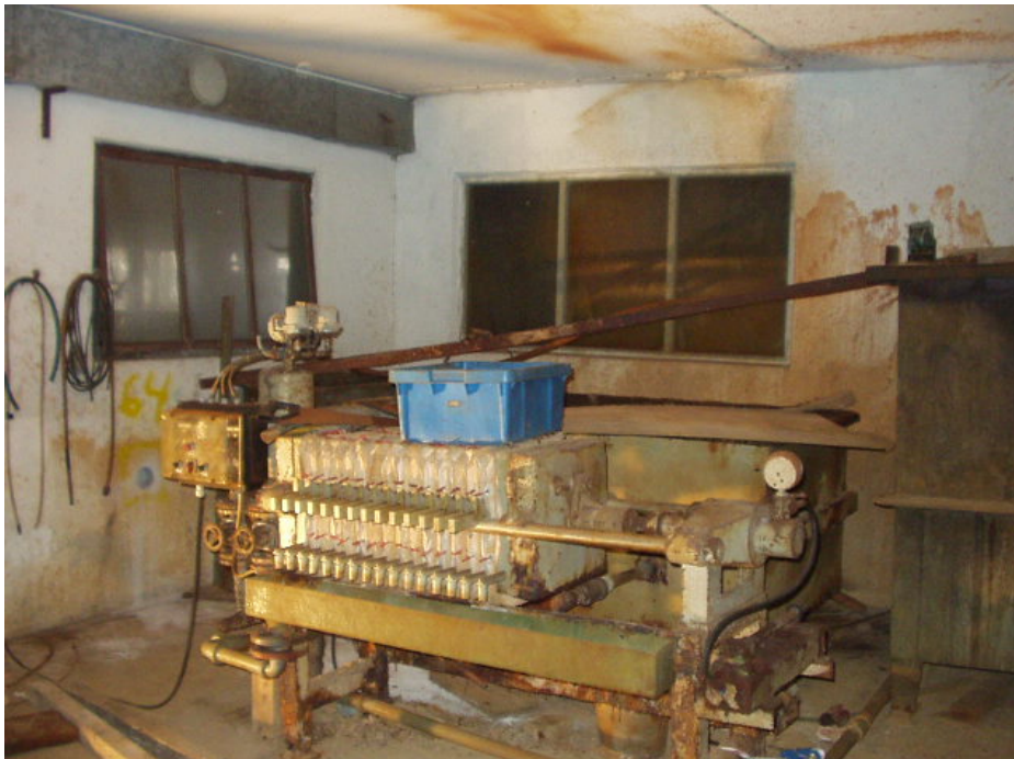
Figur 7.1 Bild av filterpress som visar hur spill på väggar koncentreras till den nedre delen av väggarna, men att pressningen har gett upphov till kraftigt spill även i taket. (Foto: Golder Associates)
