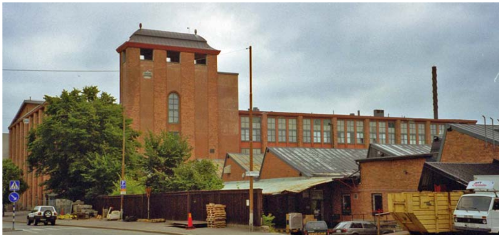
Figur 16.1 Barnängens tryckeri på Söder i Stockholm före ombyggnaden till bland annat arkitektkontor (JM).
