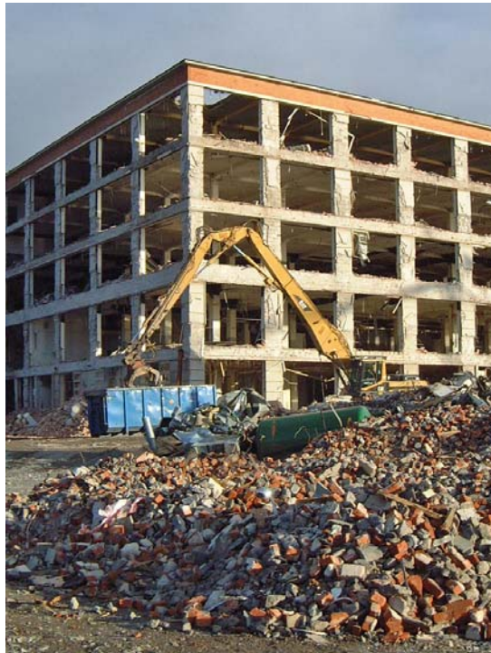
Figur 14.1 Om förorenat byggnadsmaterial rivs måste avfallet klassificeras. Ska det återanvändas måste det dessutom vara noggrant separerat (JM).
