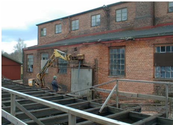
Figur 5.2 Sanering av ytskikt (foto: Golder Associates)
