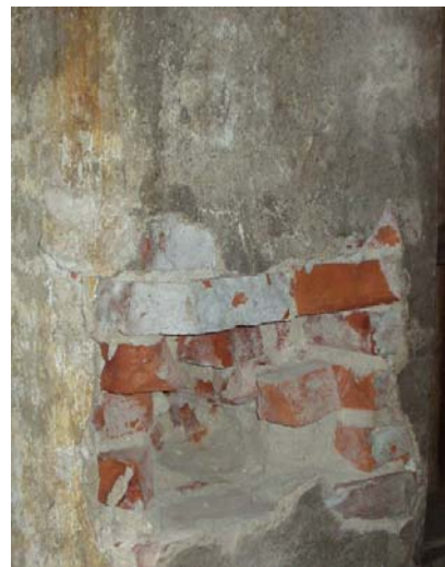
Figur 5.3 I vissa material kan halten vara högre på djupet (Foto: Golder Associates)
